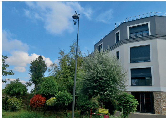
Nouvel éclairage rue Aristide Briand
